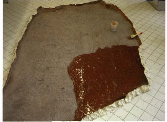
Abb. 11 Erste dünne Harzschicht.
